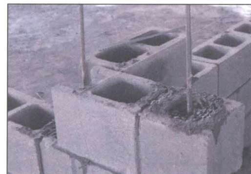
190、240厚砌块与框 架柱脱开后设芯柱
