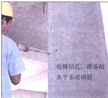
有门洞时水平系梁设在门顶
